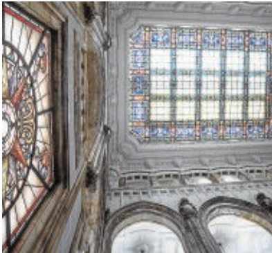
Lucernario y vidriera del Cuartel General de la Armada
